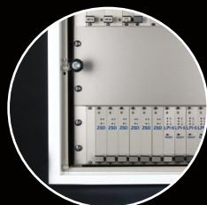
Стационарная часть системы (телефонный пост) выполнена в виде двухчастного настенного шкафчика:
